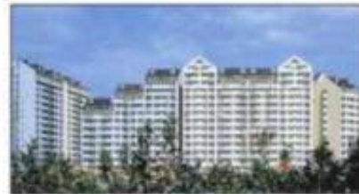
焼却熱を六甲アイランド共同住宅地区へ供給 (神戸市東部スラッジセンター)
